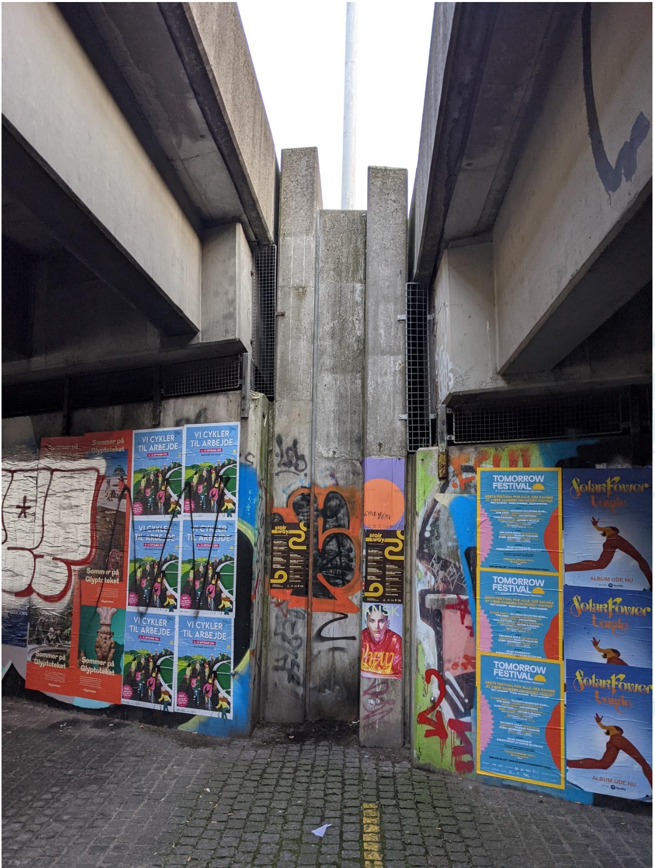
To separate vejbroer samles i en delvist sammenbygget rampe // eget foto
